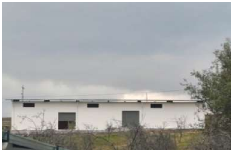
Fotografía 16. Fábrica textil en construcción
